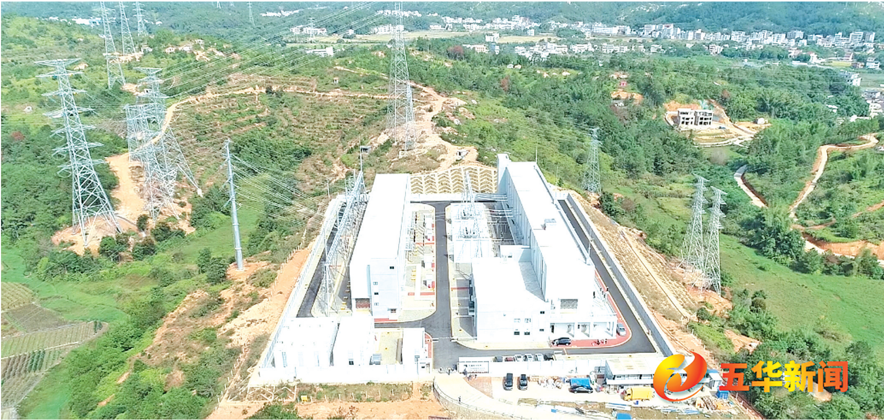
威光变电站是梅州第一座220千伏智能变电站。
