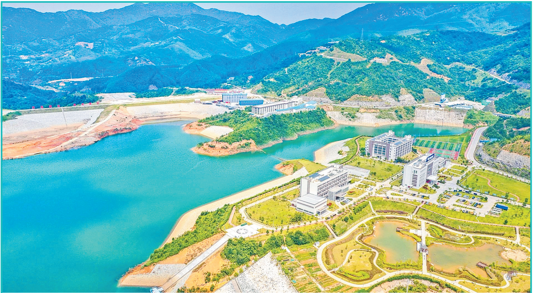
▲梅州抽水蓄能电站。
