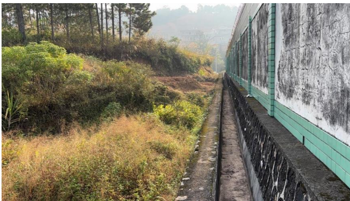
图 2.2-4 110kV 桂田变电站扩建用地现场照片图
