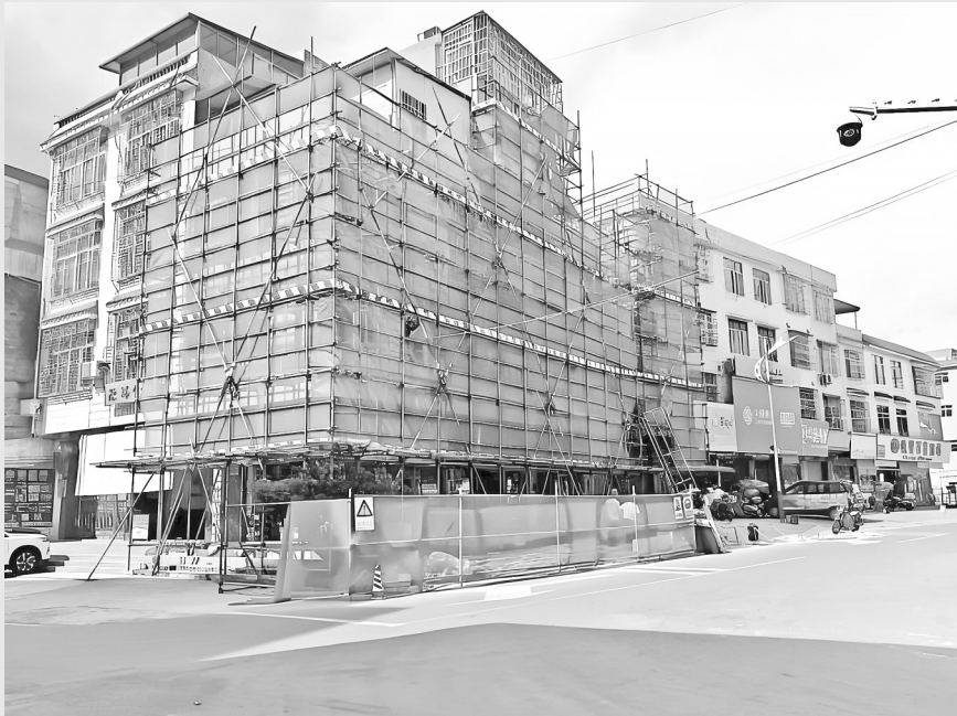
圩镇主街道民房改造中。
