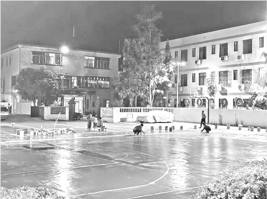
升级改造中的双华镇运动场所。
