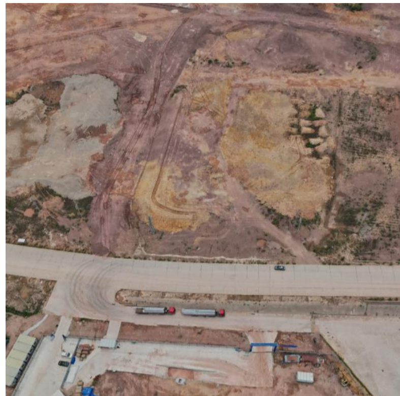
项目南面（园区道路）
