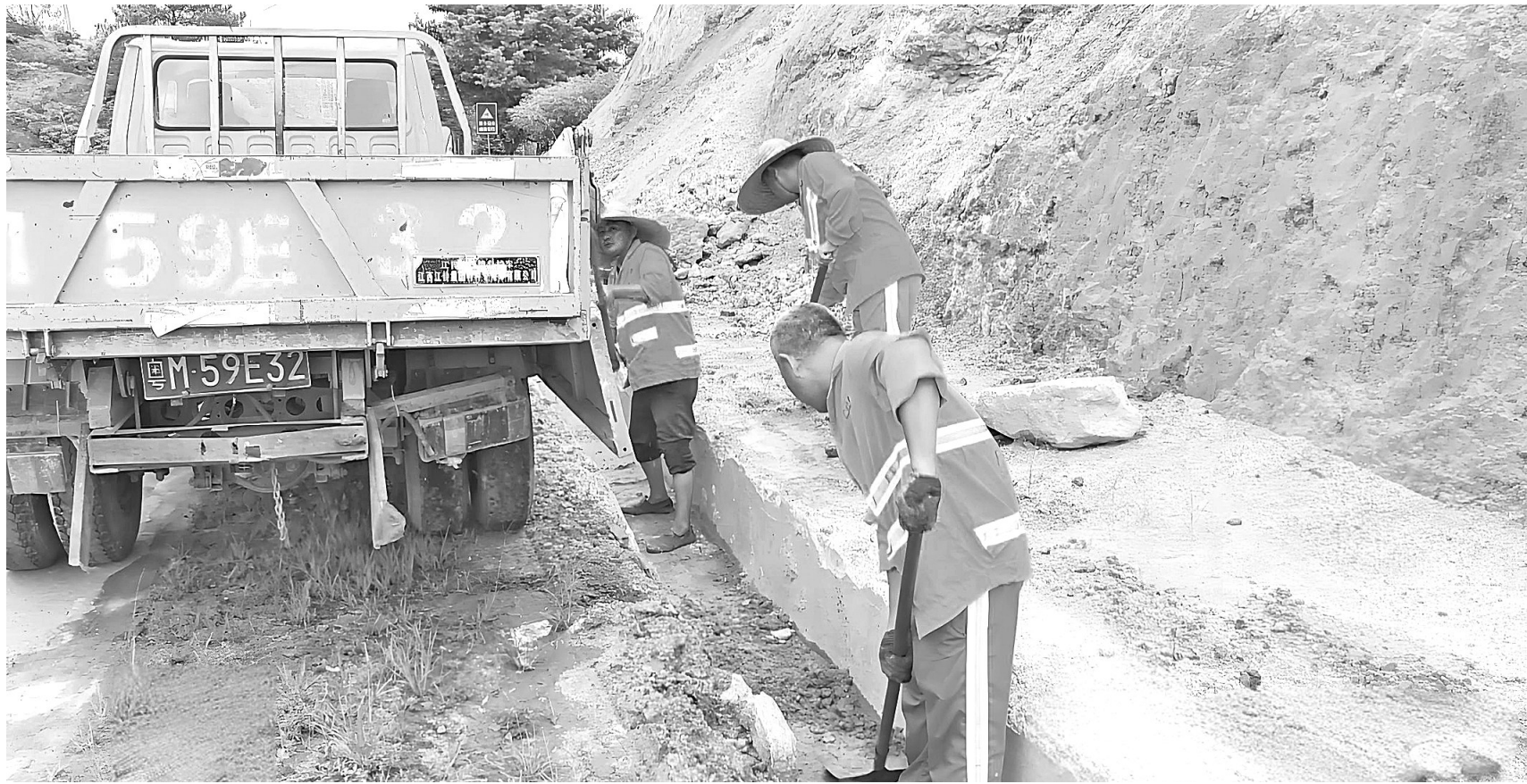
公路养护道班人员清除排水沟淤塞杂物,确保排水系统正常运行。
