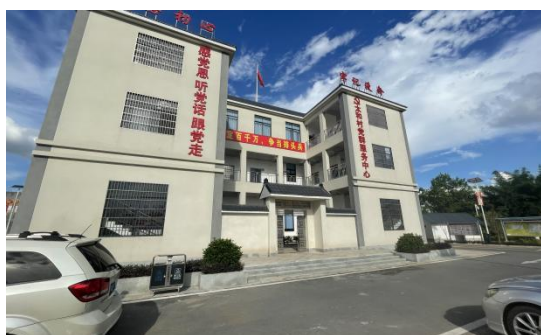
现场踏勘调研照
