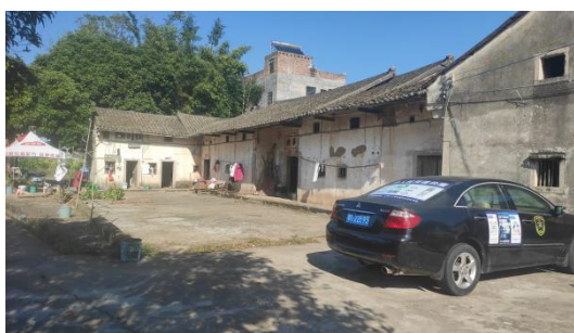
现场踏勘调研照
