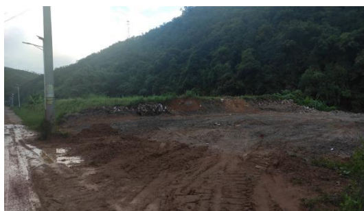
现场踏勘调研照
