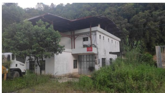
现场踏勘调研照
