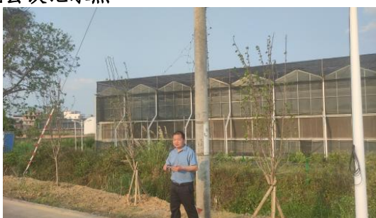
现场踏勘调研照
