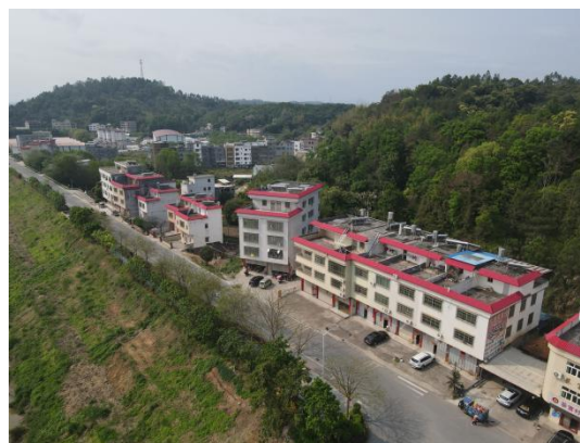
现场踏勘调研照
