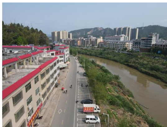
现场踏勘调研照
