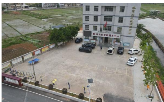
现场踏勘调研照
