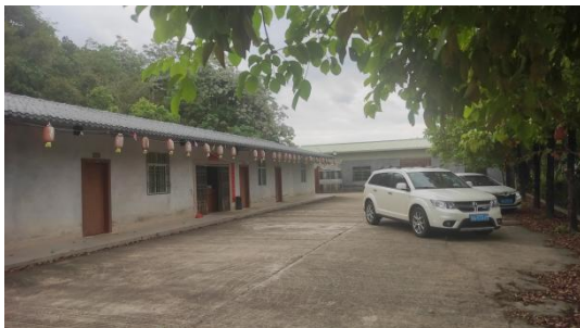
现场踏勘调研照
