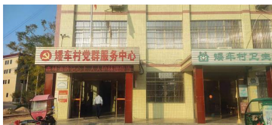
现场踏勘调研照
