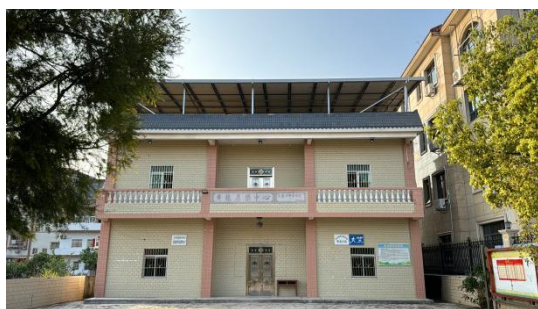
现场踏勘调研照
