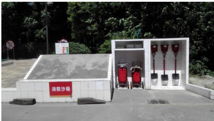
图 5.2-15 消防砂池及消防器材间示意图
