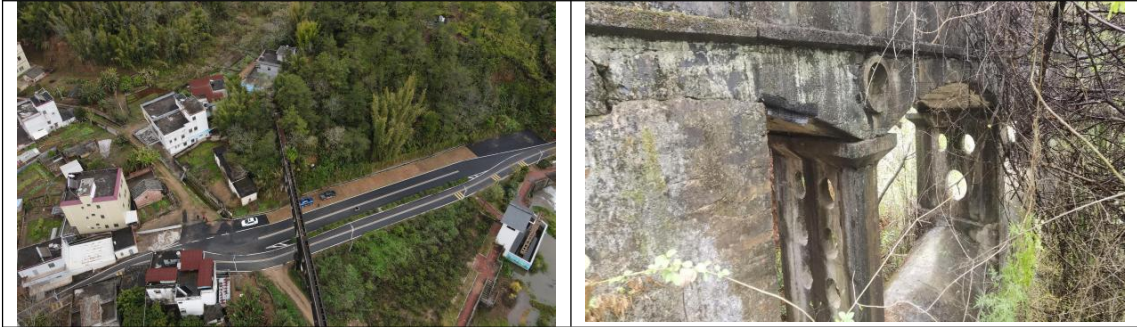
黄南支渠 6#渡槽
